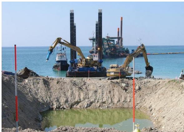
Open Trench Dry Excavations/ Χωματουργικά Ανοικτού Ορύγματος
