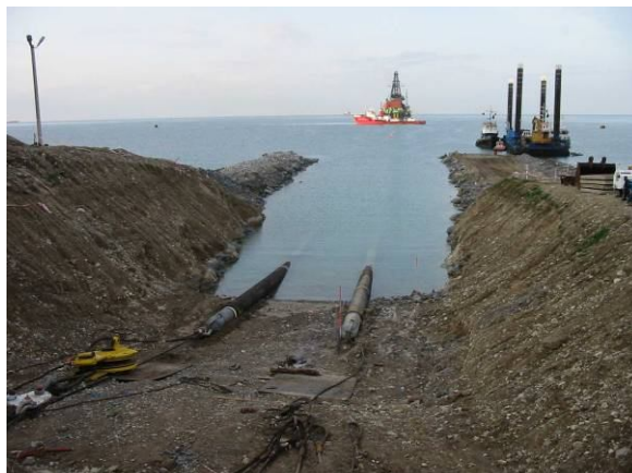
Pipe Pull Completion/ Ολοκλήρωση έλξης αγωγού
