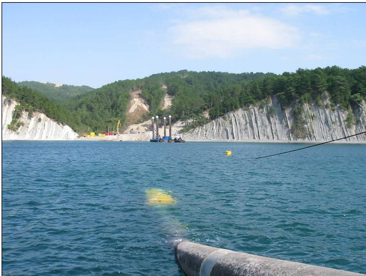
Εικόνα 1 Κατασκευή προσαιγιάλωσης του αγωγού Blue Stream – Έλξη αγωγού
